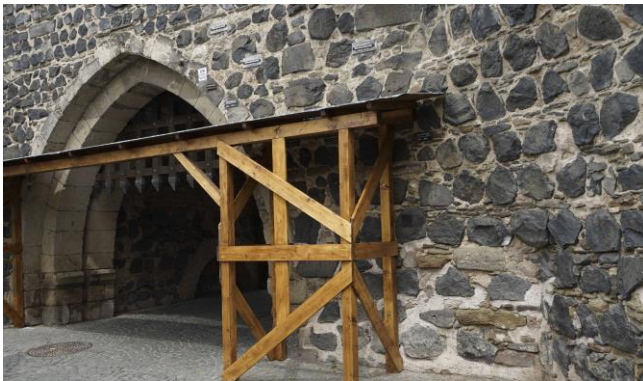
Provisorische Schutzkonstruktion Rheintor
